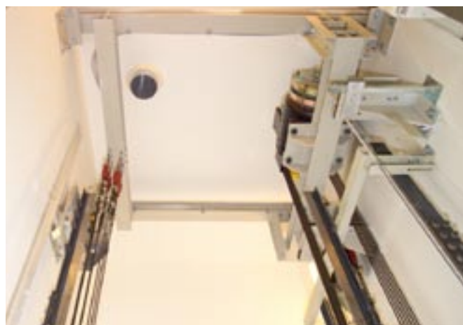
Schakttopp 2:1 utförande med gejder på varje sida
