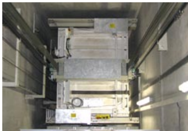
Hisskorg i schakt med gejder på två sidor i 2:1 utförande
