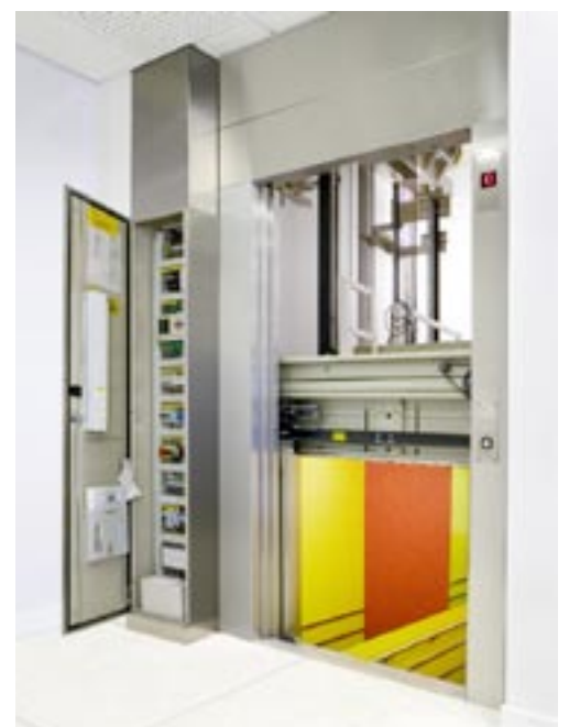
Hissens apparatskåp placeras normalt vid övre plan eller i anslutning till schakt
